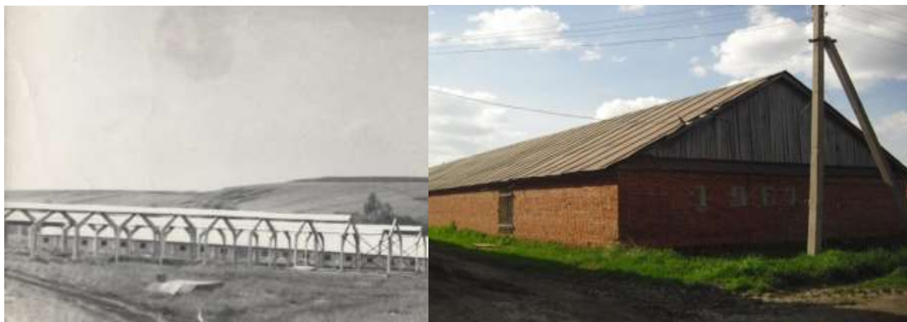
Строительство ферм Зернохранилище, построенное в 1967 г.
